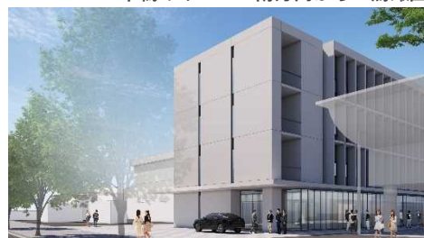
多機能講義棟東端のエントランスゾーンの様子
