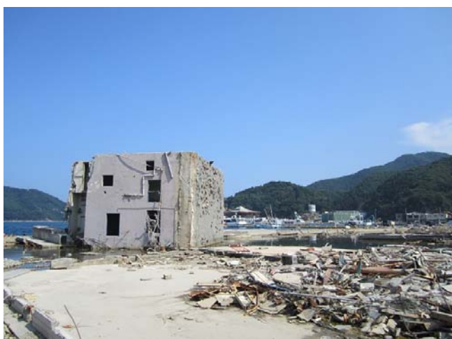
津波で倒れたコンクリート製の建物(女川町) 8月13日
