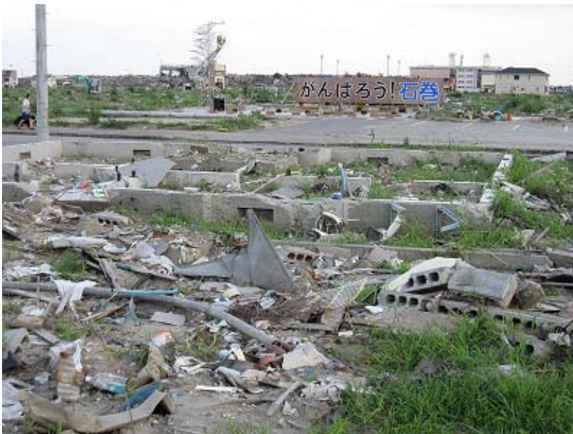
鉄筋コンクリート製の建物以外ほとんど見られない石巻市街地 8 月 11 日
